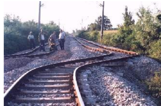
Rails courbés (séisme d'Izmit, Turquie 1999)
