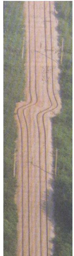
Rails courbés (séisme d'Izmit, Turquie 1999)
